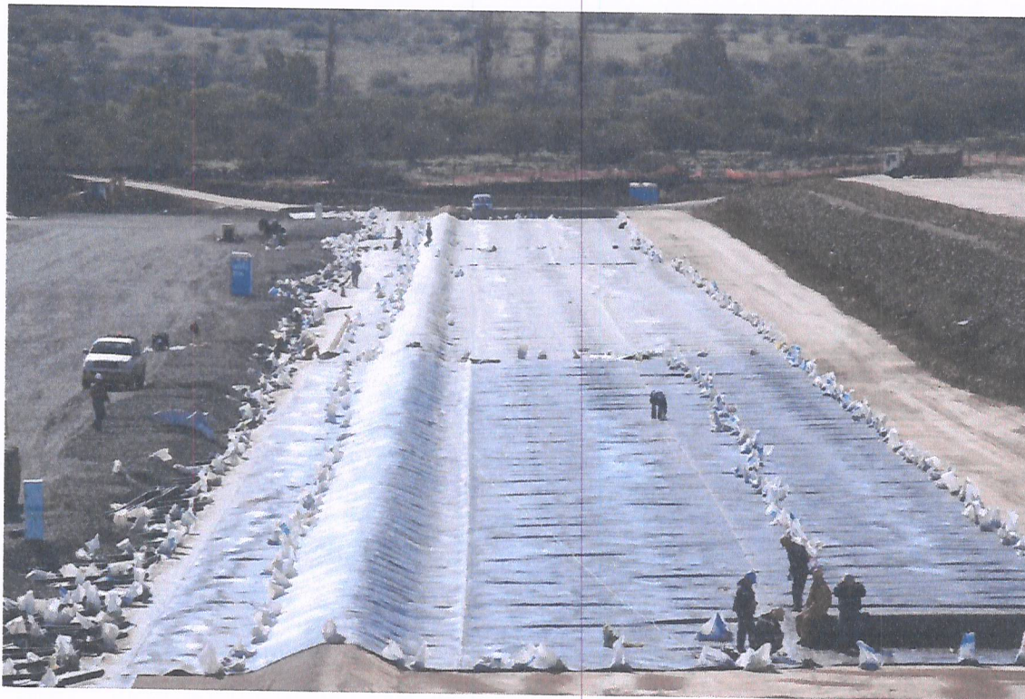
Imagen 1. Fotografía de proceso de construcción de pila de lixiviación.
